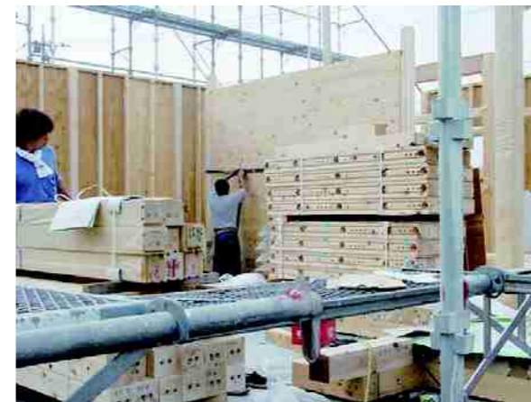
無垢材積層パネルを壁面全体に施工する
