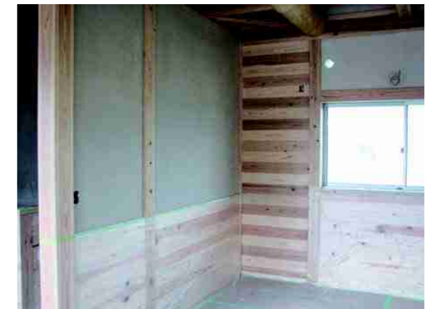
仕上げ工事を行うことなく、無垢材の積層パネルを現し仕上げにすることも可能
